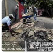
Trabajos de reparación de aceras y contenedores en Villa Progreso
